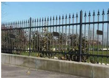
**Muro antisfondamento – Applicazione un sensore fissato al centro ogni 5m.**
