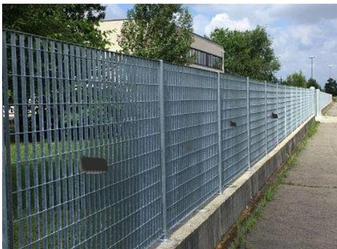
**Recinzione Elettrosaldata: Applicazione un sensore ogni 2 pannelli al centro di esso**
